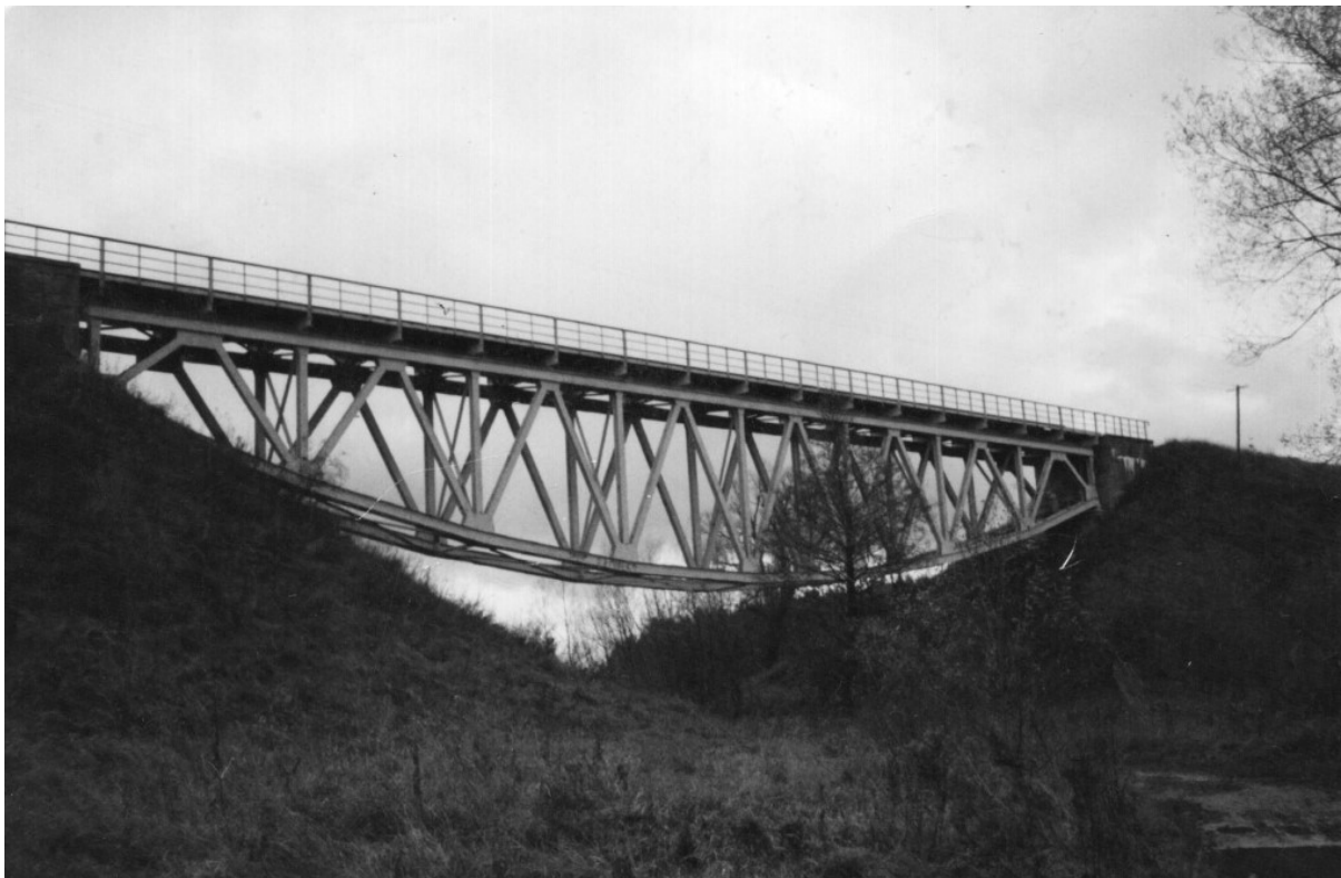
Rysunek 1. Widok mostu kolejowego
