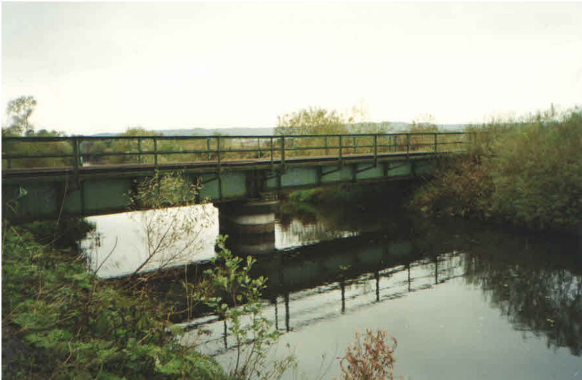
Rysunek 1. Widok remontowanego obiektu
