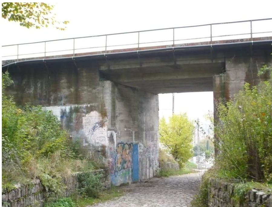
Kolejowy obiekt inżynieryjny
