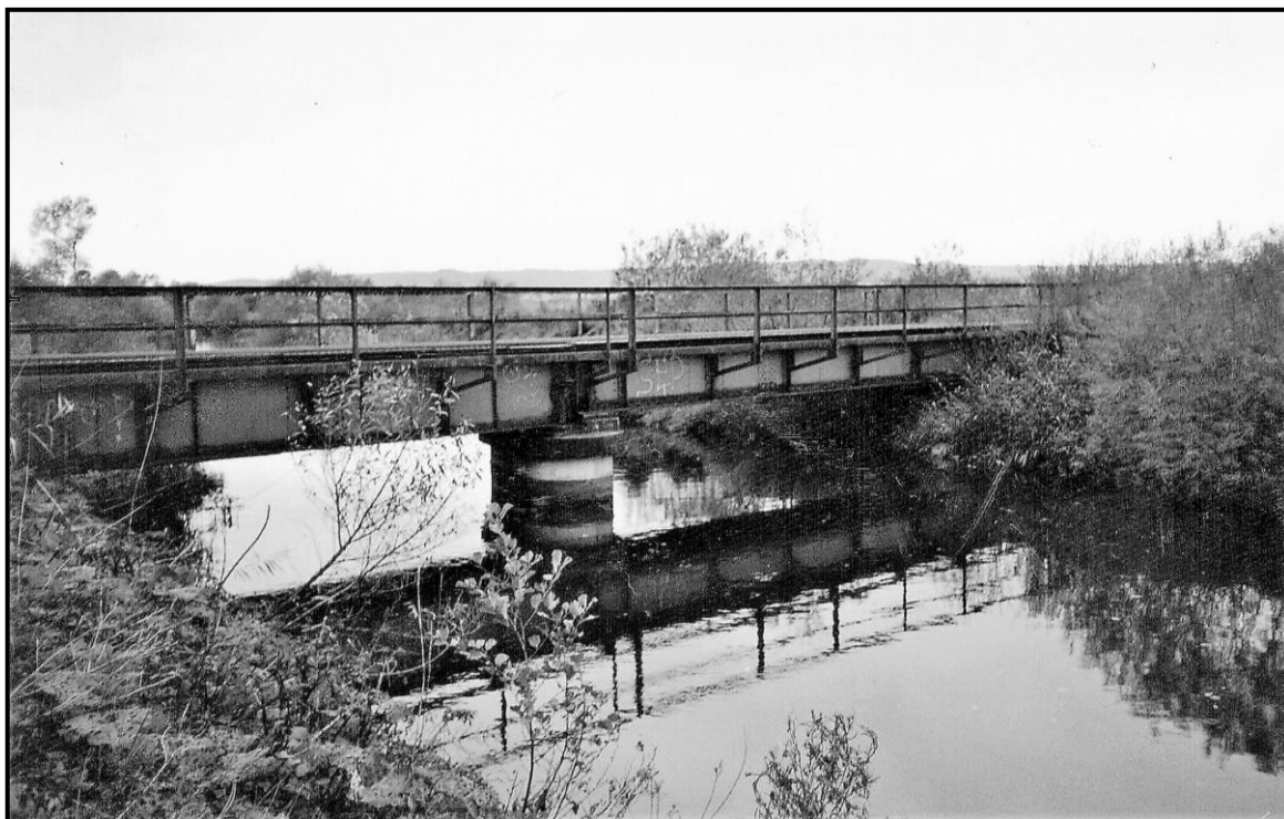
Rysunek 1. Widok mostu kolejowego
