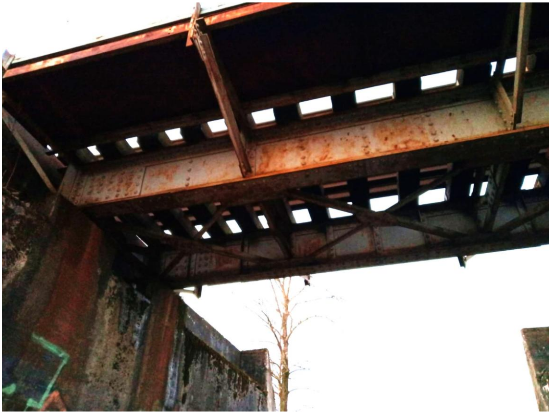
Rysunek 4. Remontowany wiadukt kolejowy
