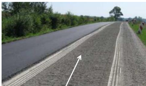
Rozsypywanie cementu w ilości 1,5 - 7,0 %
