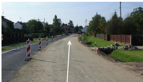
Rozkładanie kruszywa w celu optymalizacji uziarnienia
