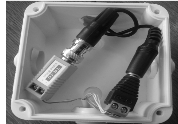
Rysunek 3. Połączenia w puszkach elektroinstalacyjnych
