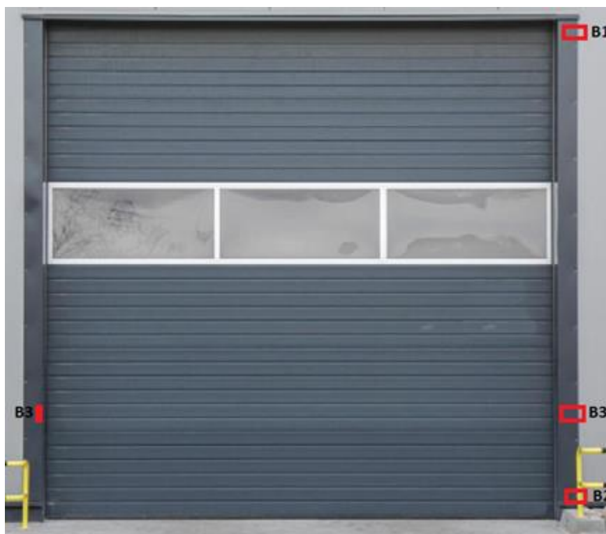
Rysunek 1. Brama przemysłowa z rozmieszczeniem czujników
