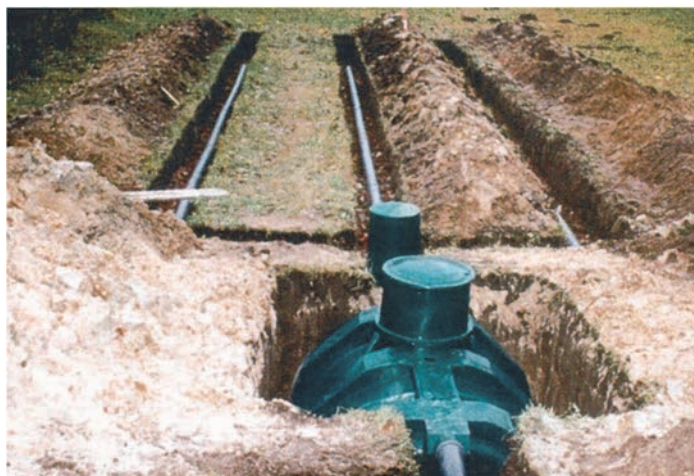
Rys. 3. Oczyszczalnia ścieków w trakcie wykonywania robót budowlanych
