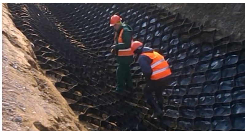
Fotografia 1. Umocnianie dna i skarp rowu materacami geokomórkowymi
