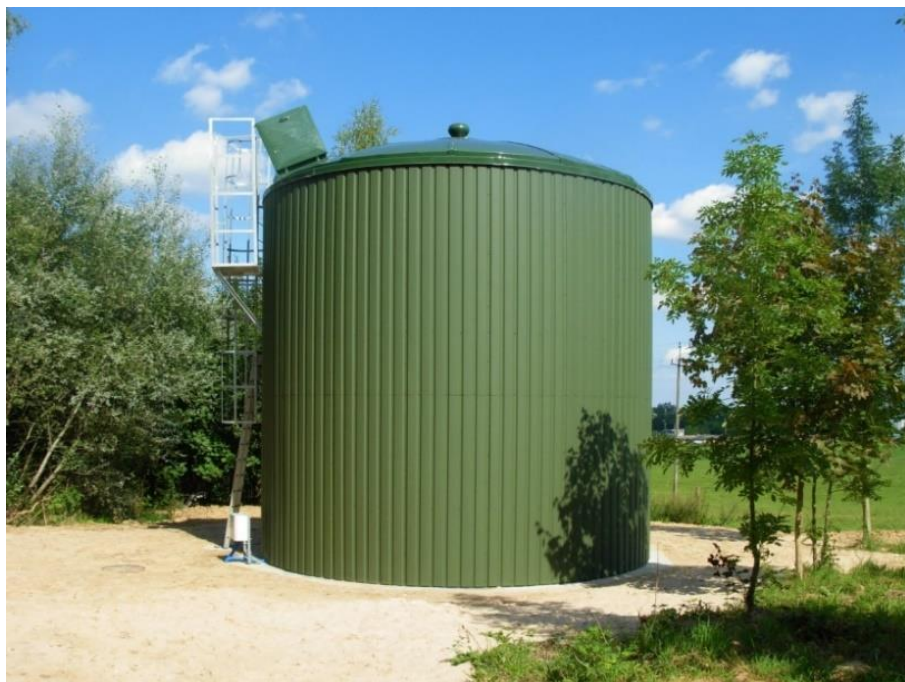
Rysunek 1. Widok zbiornika retencyjnego wody czystej
