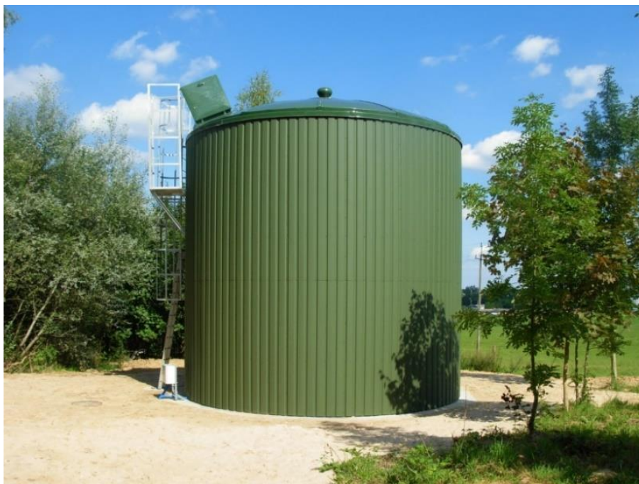
Rysunek 1. Widok zbiornika retencyjnego wody czystej
