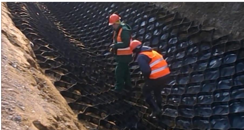
Fotografia 1. Umocnianie dna i skarp rowu materacami geokomórkowymi
