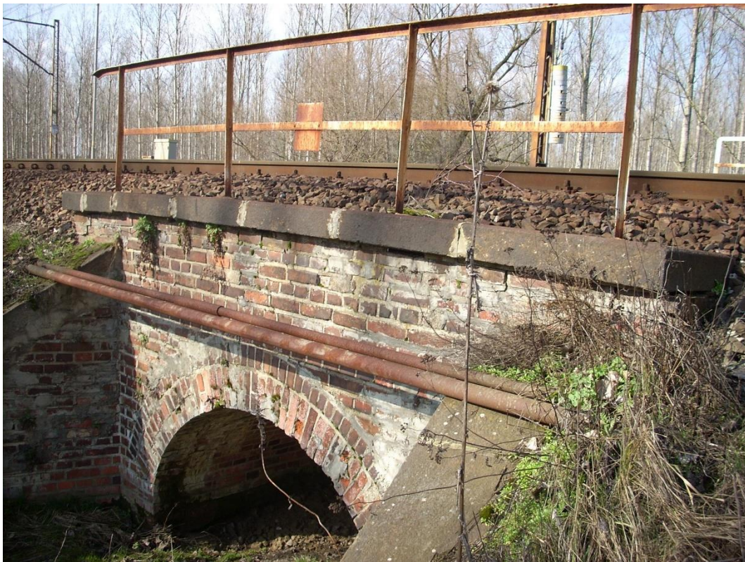
Ilustracja 1. Kolejowy obiekt inżynierski w km 108,650 linii kolejowej nr 273
