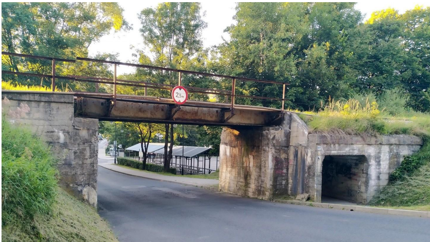
Ilustracja 1. Kolejowy obiekt inżynieryjny w km 149,250 linii kolejowej nr 108
